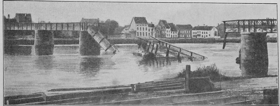
Die von deutschen Pionieren bereits wiederhergestellte gesprengte Maasbrücke bei Bifé.
