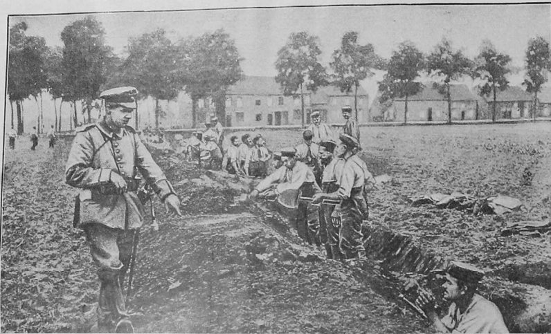
Mannschaften beim Ausheben eines Schützengrabens.
