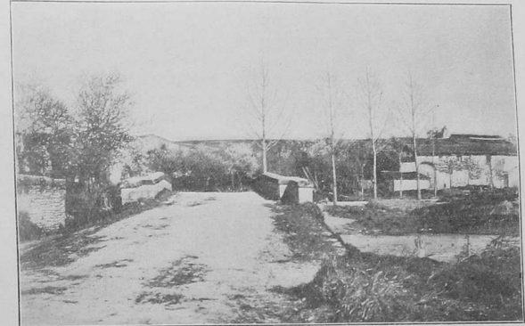
Migneville. Die Brücke über die Moselle.
