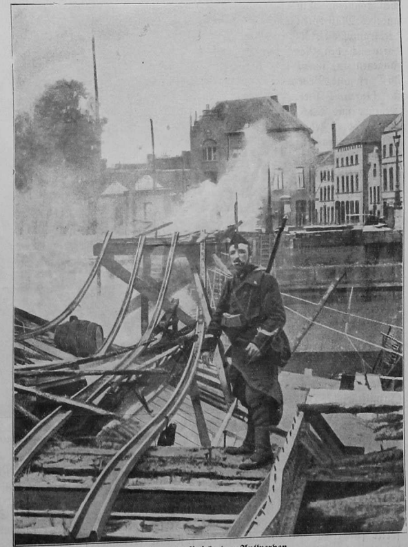
Gesprengte Brücke vor Antwerpen im Augenblick unmittelbar nach der Sprengung.
