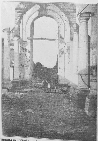
Haupteingang der Kirche in Herbécourt von innen nach der Beschädigung.
