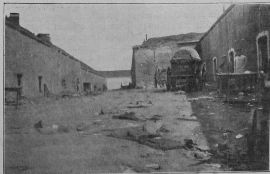
Ein Graben des eroberten Forts Camp des Romains.
