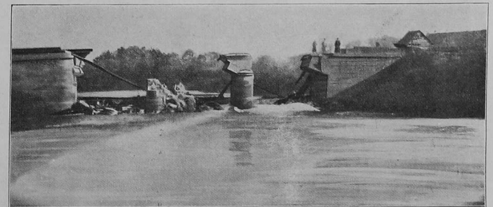
Blick auf die von den Engländern gesprengte Duse-Kanal-Brücke bei Saanpign.
