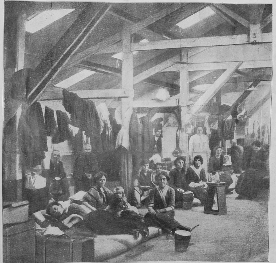
Blick in die Frauenabteilung des Zivilgefangenenlagers in Perigueur.
