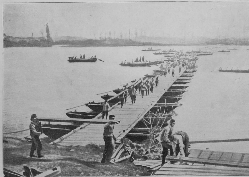
Französische Pioniere bauen eine Schiffbrücke.
