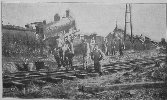
Pioniere brachten die zur Fortführung unserer Geschütztransporte von Antwerpen abgelassenen fahrradlosen Eisenbahnszüge zur Entgleisung.
