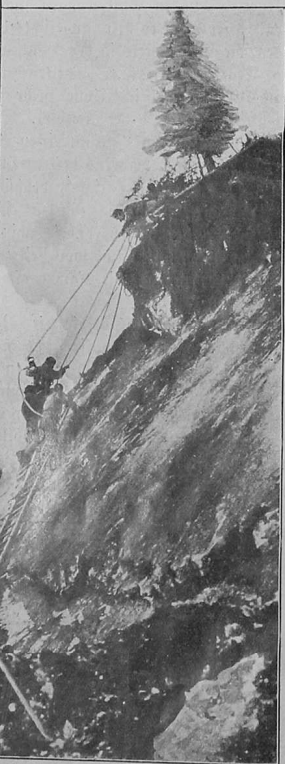
Schweizerische Pioniere bei Sprengarbeiten zur Grenzbefestigung.
