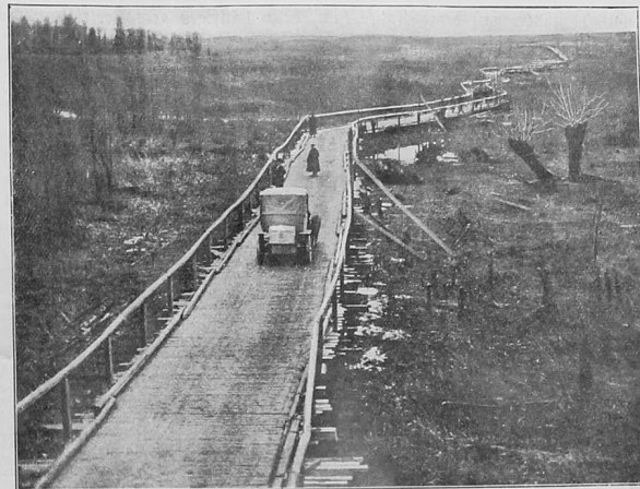
Eine von 600 deutschen Pionieren im Überschwemmungsgebiet von Obern in 5 Tagen hergestellte 500 Meter lange Brücke.
