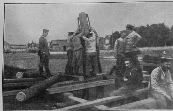
Pioniere beim Rammen von Pfählen für Brückenbauten.
