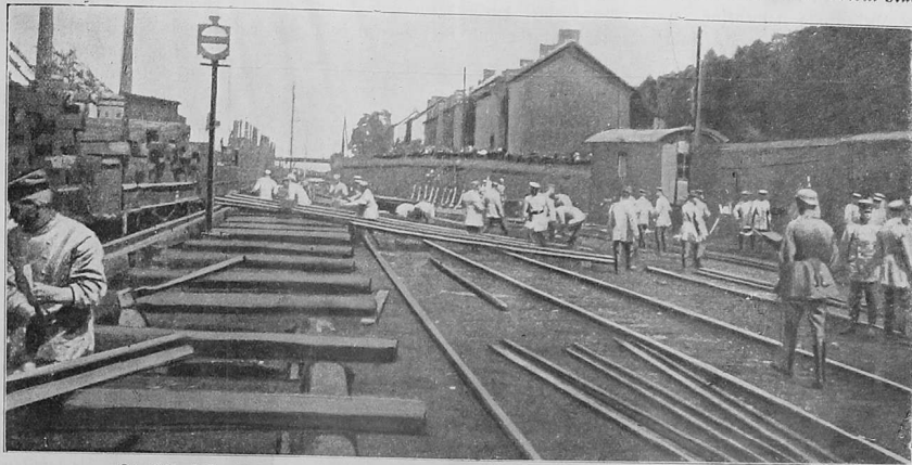
Die Eisenbahn ist das wichtigste Verkehrsmittel im Kriege. Eisenbahntruppen bei der Arbeit.
