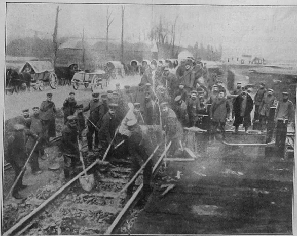
Deutsches Militär beim Bau einer Eisenbahnstrecke neben einer Etappenstraße.
