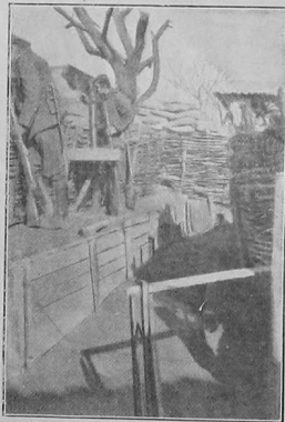
Zwei Mann auf Graben-Posten hinter Stahlschildern, im Hintergrund eine querstehende Schützengraben aus Sandbagpackung.
