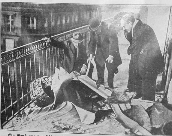
Ein Gruß aus den Lüften. Das von einer Fliegerbombe gerissene Loch im Dach eines Pariser Hauses.
