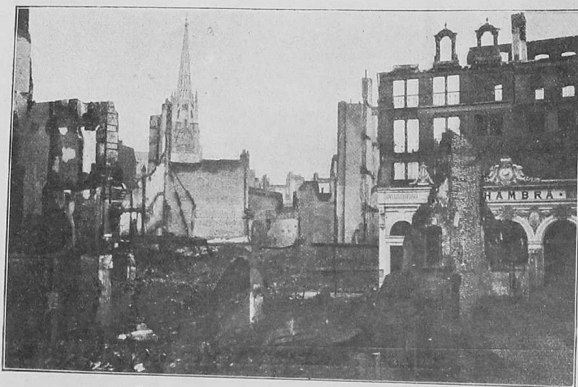
Blick in ein zerstörtes Häuserviertel von Lille.
