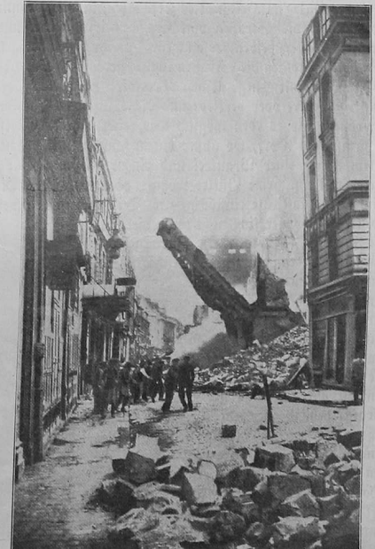
Ein einstürzendes Haus in Lille während des Brandes.
