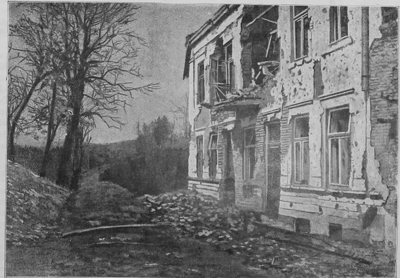
Eines der äußersten Häuser von Gorlice mit unzähligen Geschosspuren.
