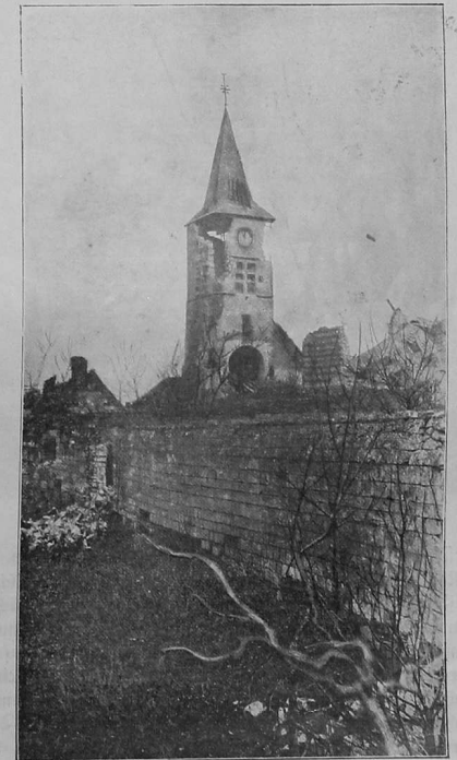
Die Kirche von Ebelus mit der Kirchhofsmauer.
