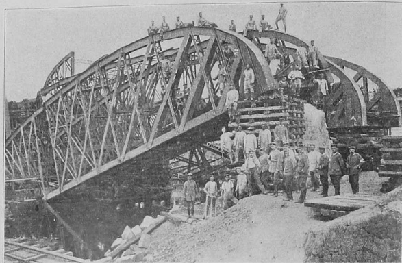
Deutsche Pioniere „kurieren“ eine gesprengte Weichselbrücke.
