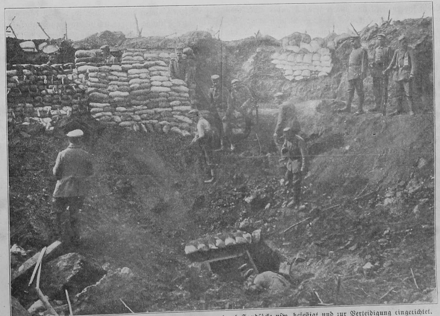
Der Trichter einer gesprengten Mine wird nach der Besetzung durch Sandfüße usw. besetzt und zur Verteidigung eingetüchelt.
