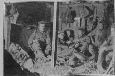
Unterstand mit einer senkrechten Mittelstütze.
