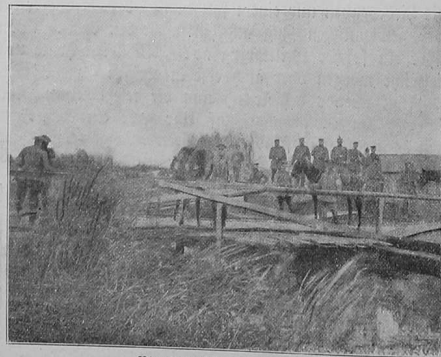
Pionierbrücke bei Peronne.
