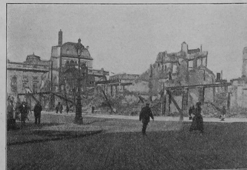
Das gänzlich zerstörte Börsenviertel in Lille.
