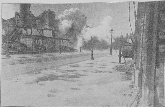
Die aus Sicherheitsgründen wegen Einsturzgefahr verfügte Sprengung des Caffee Jean in Lille.
