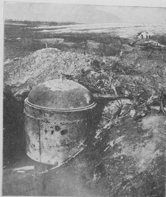
Ein durch das Trommelfeuer wohl bloßgelegter, aber nicht zerstörter Panzerturm an der Westfront.
