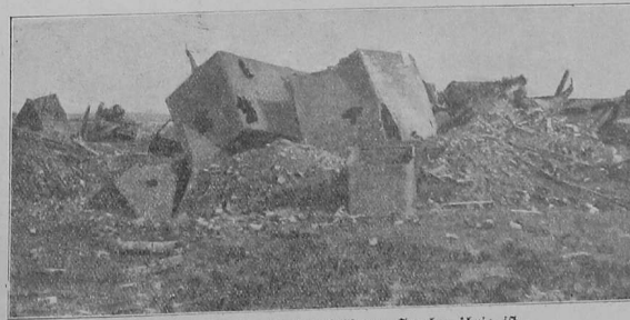
Was noch von der Zuckfabrik von Soupez übrig ist.
