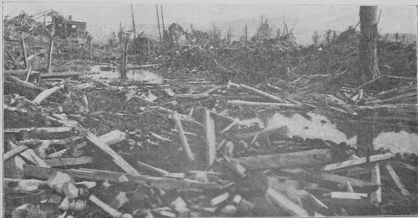
Was übrigbleibt! Das Stummereid von Soupez nach dem Bombensturz.
