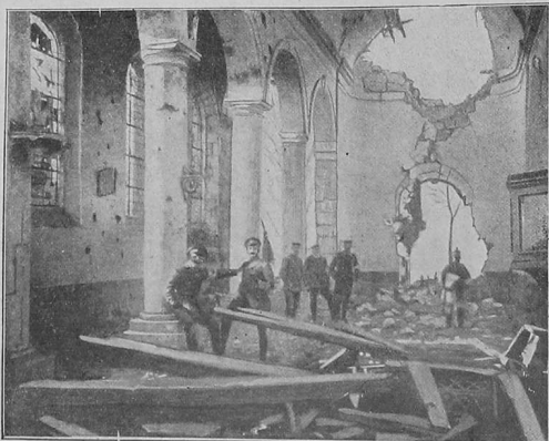
Das Innere einer zerstörten Kirche auf dem westlichen Kriegsschauplatz.
