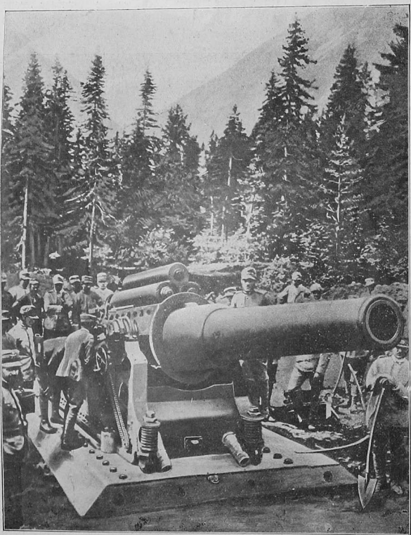
Ein schweres italienisches Geschütz in der Montage.
