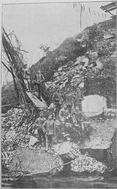
Bei den Resten einer gesprengten Brücke in Nordfrankreich.
