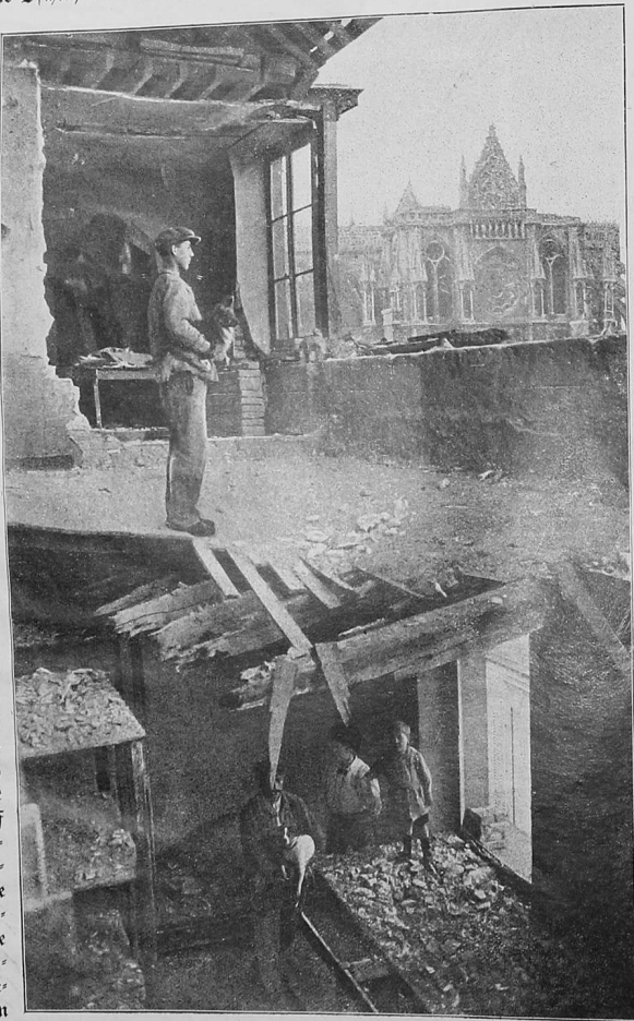
Wirkung einer schweren deutschen Granate an einem getroffenen Wohnhaus.
