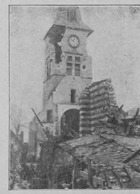
Thelus bei Uras. Kirche, nachdem das Gewölbe eingestürzt.
