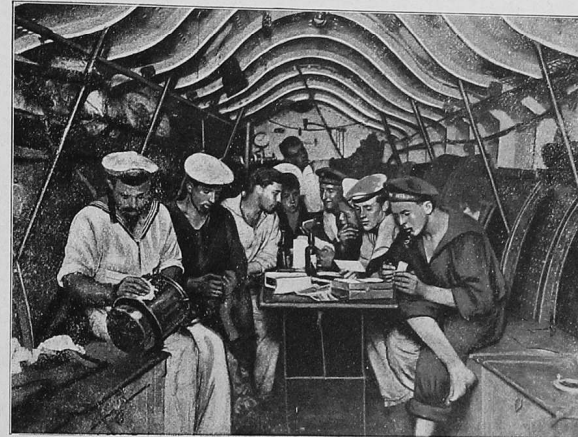
Speiseraum in einem Unterseeboot.
