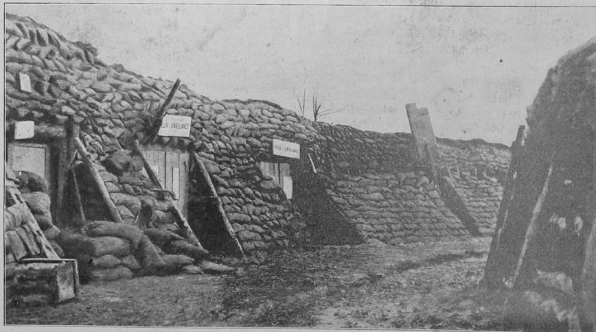
Eine massiv ausgebaute feindliche Sandbagstellung.
