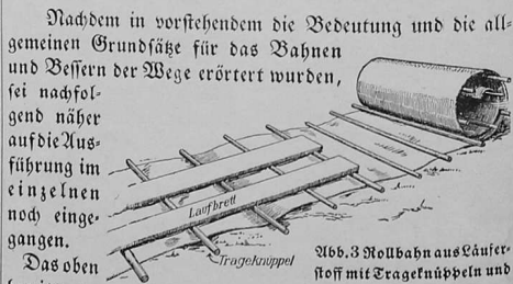
Abb. 3. Rollbahn aus Laufbrettern mit Tragknüppeln und Laufbrettern.
