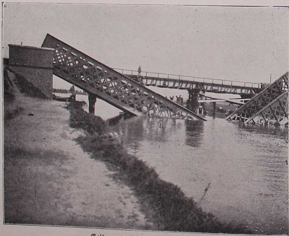
Sprengte Brücke über die Ebs.
