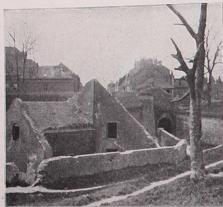
Der Drüseingang nach Warneton.
