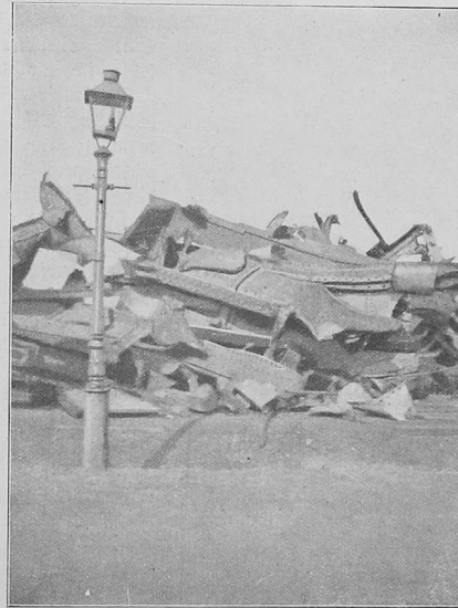
Abb. 1 Die Überbleibsel einer gesprengten Brücke.
