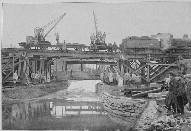
Abb. 4. Eisenbahntuppen bei Wiederherstellungsarbeiten einer vom Feind zerstörten Eisenbahnbrücke.
