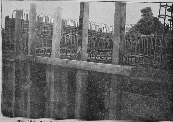
Abb. 16a. Verankerungsarbeiten, die letzte Arbeit vor dem Betonieren.
