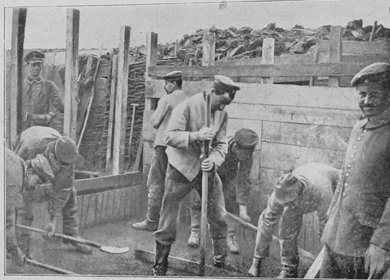
Abb. 16. Betonieren der Sohle eines Unterstandes.
