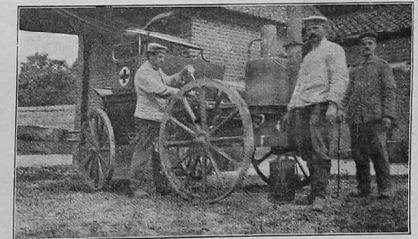
Desalierapparat für Trinkwasser.
