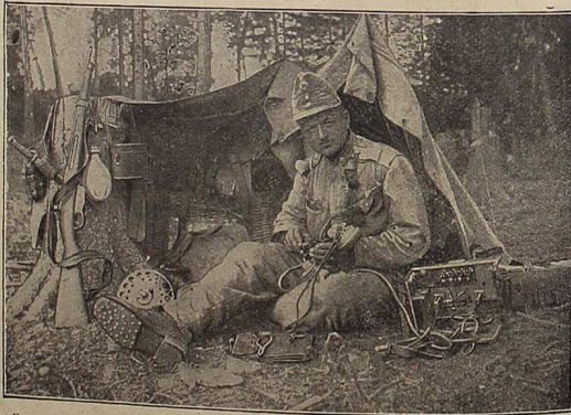
Österreichische „Telephonzelle“ im Wald von Pinsk. Der Telephonist ist mit der Prüfung von Telephonkatheten beschäftigt.
