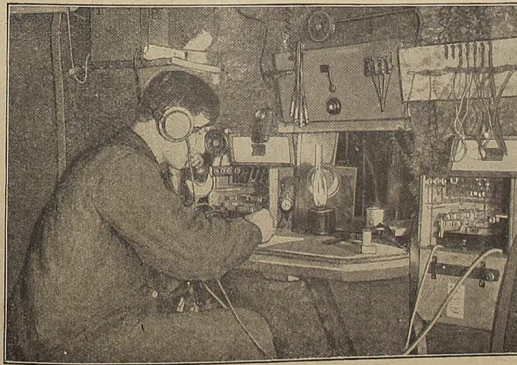
Telephonzentrale im Unterstand eines Kommandeurs an der Tiroler Front.
