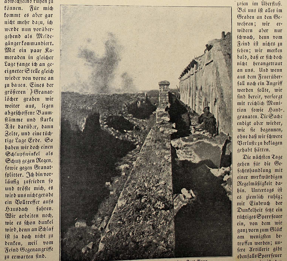
Blick auf die zerstörten Befestigungsanlagen von Fort Vaux.
